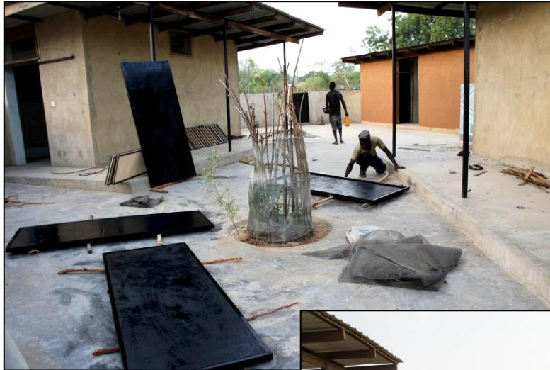
Umbauarbeiten im Training Center (Fotos: Baerbel Mueller)
